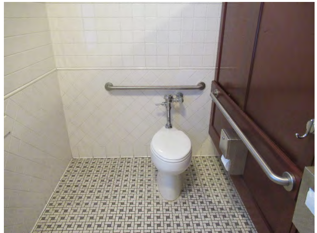
106. An Accessible toilet.
